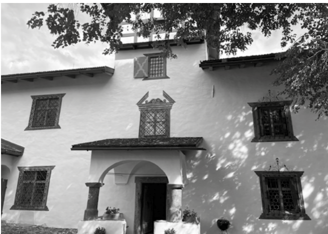
Innenhof des Sprecher-Hauses in Luzern. Foto Christian Aeberli.
